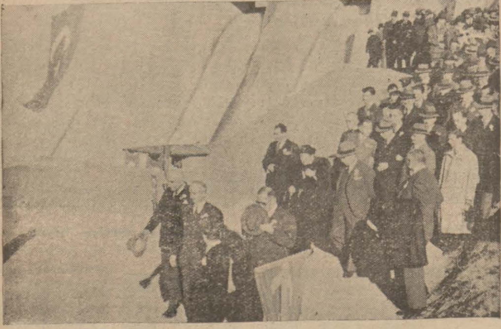
Başbakanın eliyle Ankara'daki çubuk barajı açıldı
